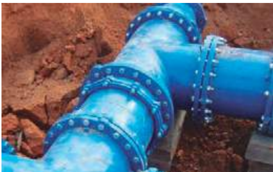
1. Redes de agua potable y alcantarillado.
