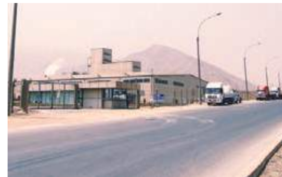
3. Vías asfaltadas y veredas a nivel de afirmado.
