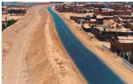
5. Vías de acceso al proyecto pavimentadas con concreto.
