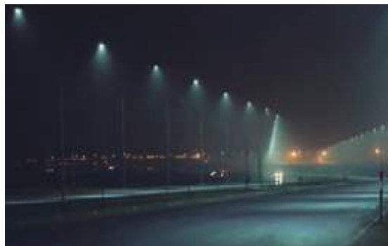
2. Sistema de utilización de energía eléctrica en media tensión 22.9 Kv subterráneo y red pública de iluminación LED.
